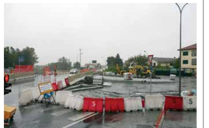
Savigliano: i lavori in corso presso l'incrocio - Servizio a pagina 6
