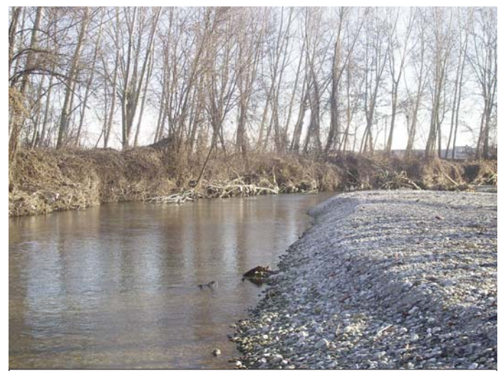
I lavori partiranno dalla zona del Morrè entro fine anno
