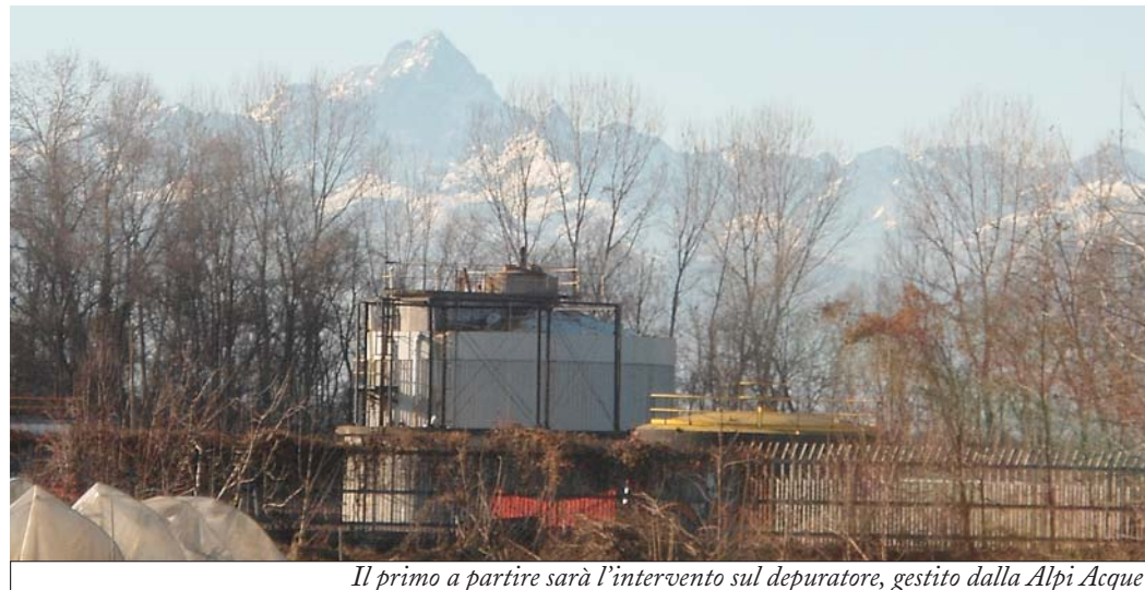
Il primo a partire sarà l'intervento sul depuratore, gestito dalla Alpi Acque
