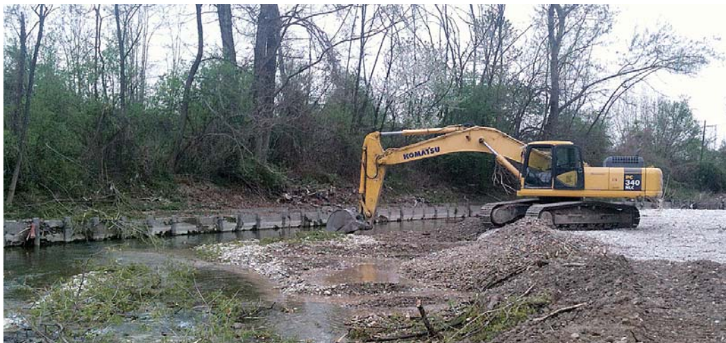
Una ruspa al lavoro nel letto del Mellea, che sarà abbassato ed allargato per far passare più acqua
